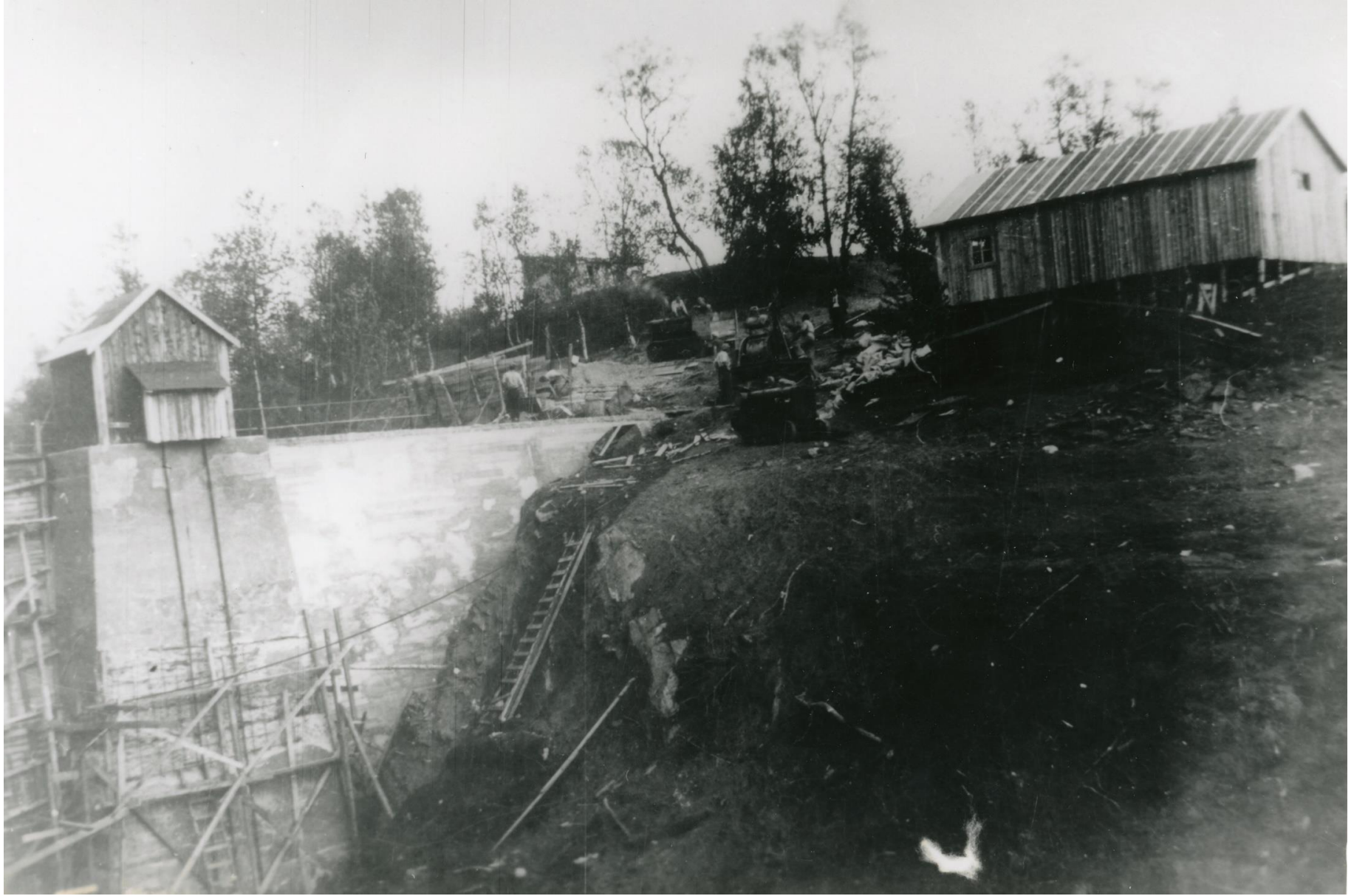
I 1946 var det lekkasjer gjennom den opprinnelige betongtettingen. Det ble derfor laget en påstøp på vannsiden av demninga. Her ser vi anleggsvirksomheten med nedtappet dam. Nedenfor brakka til høyre ble det i 2010 sprengt et vannløp for å senke vannstanden permanent ca. 1,2 m.
